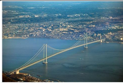
明石海峡大橋
