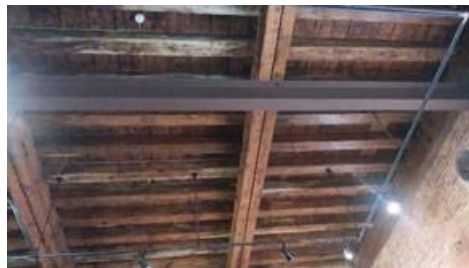
① 天井は建設当時のまま。米国からのオレゴン松を使用
