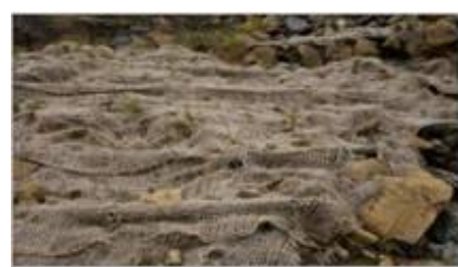
筋工の設置と緑化ネットの敷設
