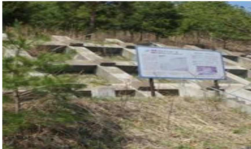
「法枠工とアンカー工」施工写真
